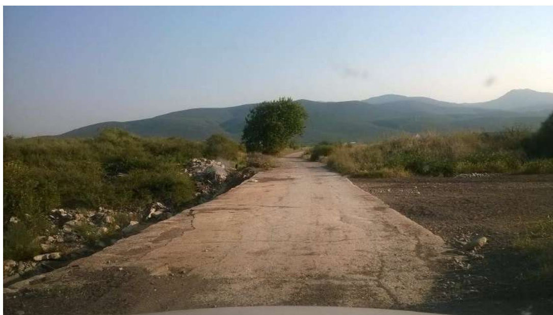
Φωτογραφίες 1 έως 6: Υφιστάμενη κατάσταση αγροτικής οδού Ζερέλια - Ευξεινούπολη
