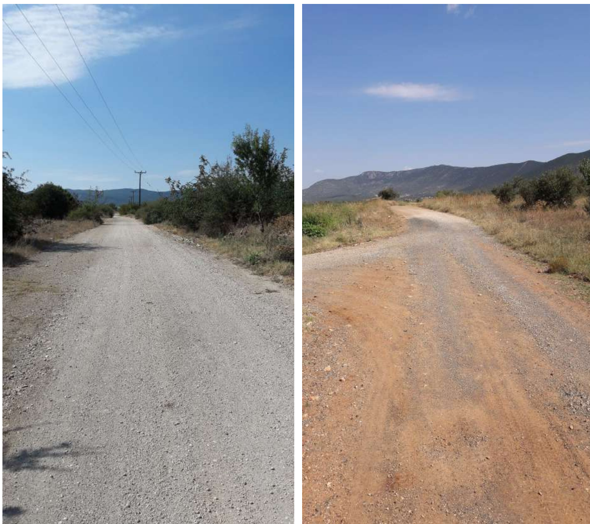
Φωτογραφίες 11 έως 20: Υφιστάμενη κατάσταση αγροτικής οδού θέση Καζάρμα - Αλάη
