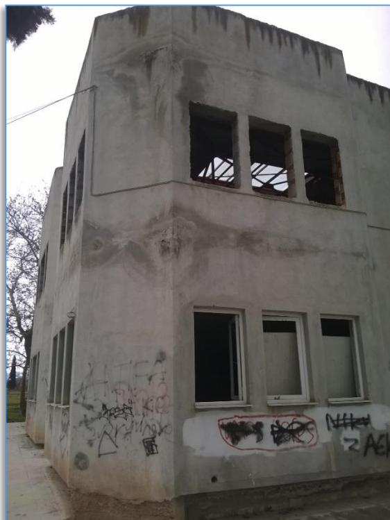
Φωτογρ.03 Το πολιτιστικό κέντρο υπό κατασκευή
