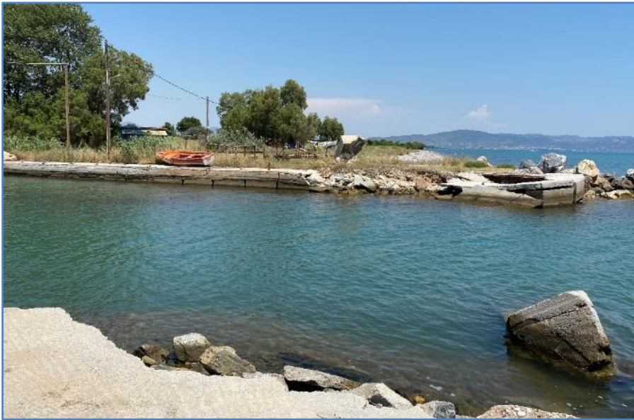
Φωτογραφία 3-7: Άποψη του βόρειου κρηπιδώματος της εσωτερικής λιμενολεκάνης του καταφυγίου
