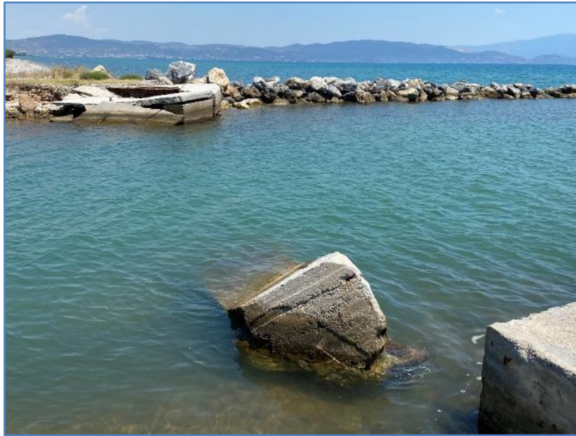
Φωτογραφία 3-9: Άποψη του ίδιου τμήματος βόρειου κρηπιδώματος
