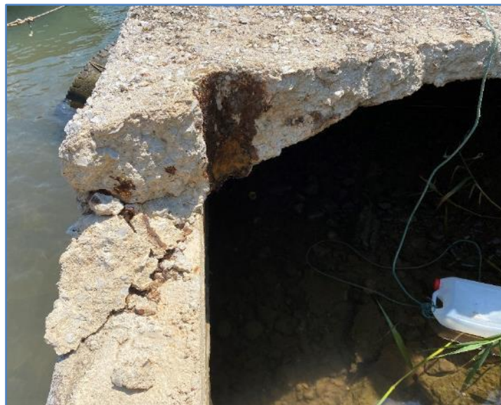
Φωτογραφία 3-15: Άποψη του πέρατος του ευθύγραμμου τμήματος των κρηπιδωμάτων της νότιας πλευράς
