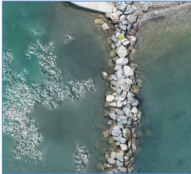
Φωτογραφία 3-2: Άποψη της δόμησης του προσήνεμου μώλου του καταφυγίου
