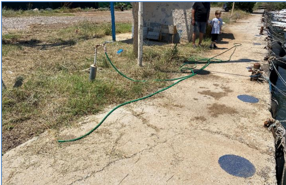
Φωτογραφία 3-13: Άποψη του νότιου τμήματος της χερσαίας ζώνης και των κρηπιδωμάτων της
