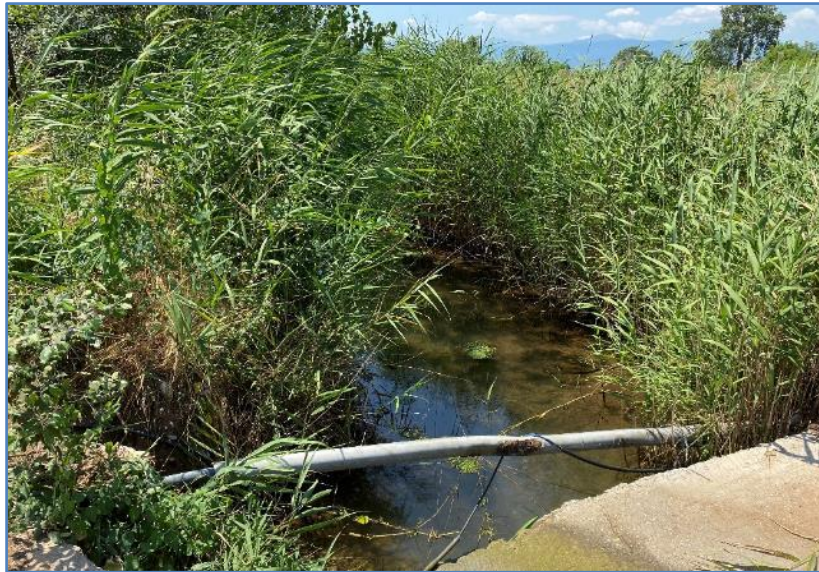
Φωτογραφία 3-21: Άποψη του αρδευτικού καναλιού που καταλήγει στη λιμενολεκάνη του καταφυγίου
