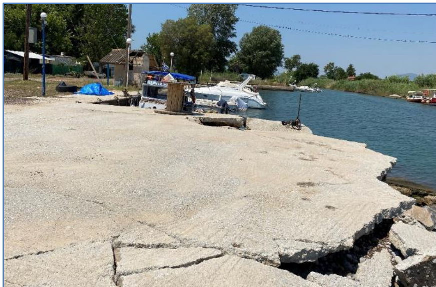
Φωτογραφία 3-10: Άποψη του κρηπιδώματος στη νότια πλευρά της λιμενολεκάνης
