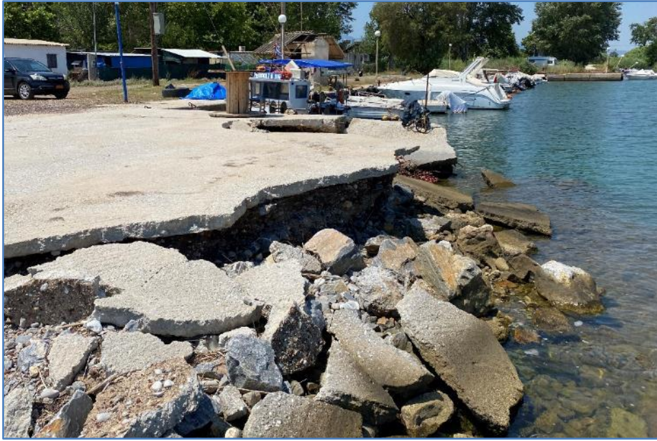
Φωτογραφία 3-11: Άποψη του κρηπιδώματος στη νότια πλευρά της λιμενολεκάνης
