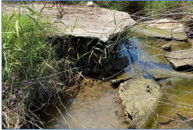
Φωτογραφία 3-17: Πλήρης κατάρρευση του γωνιακού τμήματος της υφιστάμενης κρηπίδωσης
