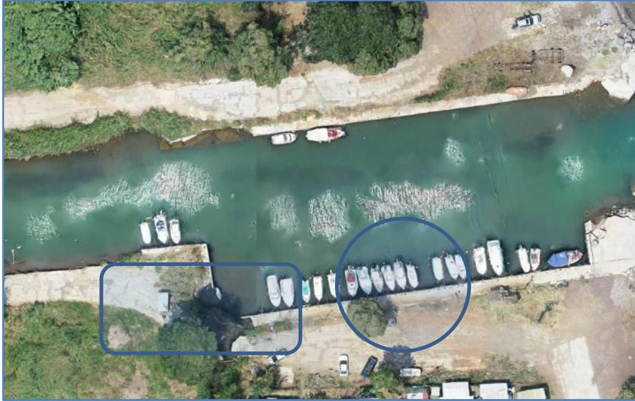
Φωτογραφία 3-14: Άποψη του νότιου κεντρικού τμήματος των κρηπιδωμάτων της εσωτερικής λιμενολεκάνης
